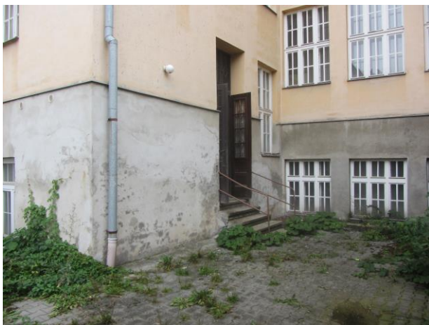
dvorní fasády – degradace omítkových vrstev soklu
