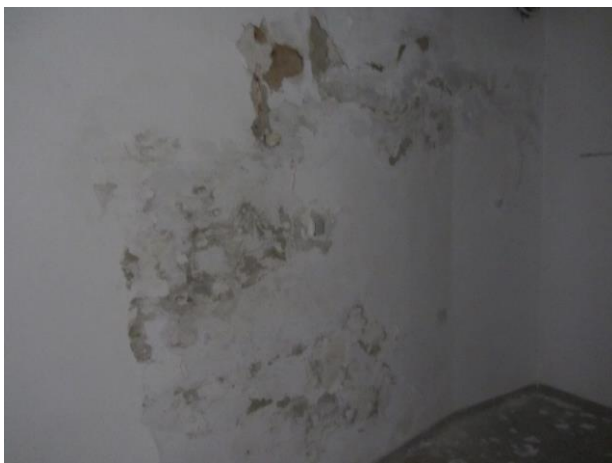
příklad rozpadu omítkových vrstev – I. NP
