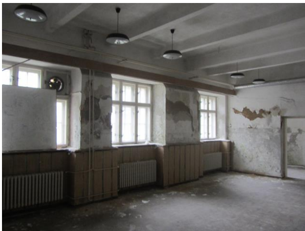
příklad rozpadu omítkových vrstev – I. PP
