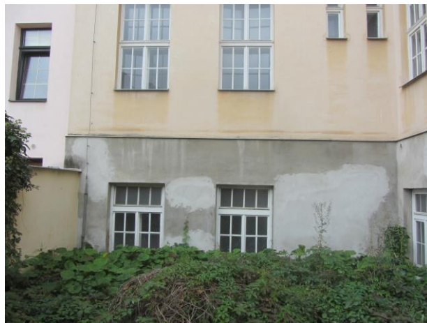
dvorní fasády – nevhodné místní doplňky omítkových vrstev (bílá neznamená vápenná)
