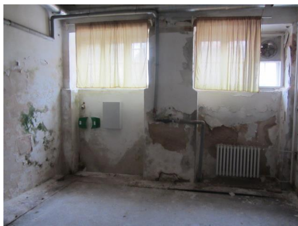
příklad rozpadu omítkových vrstev – I. PP
