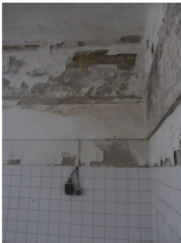
příklad rozpadu omítkových vrstev – I. PP
