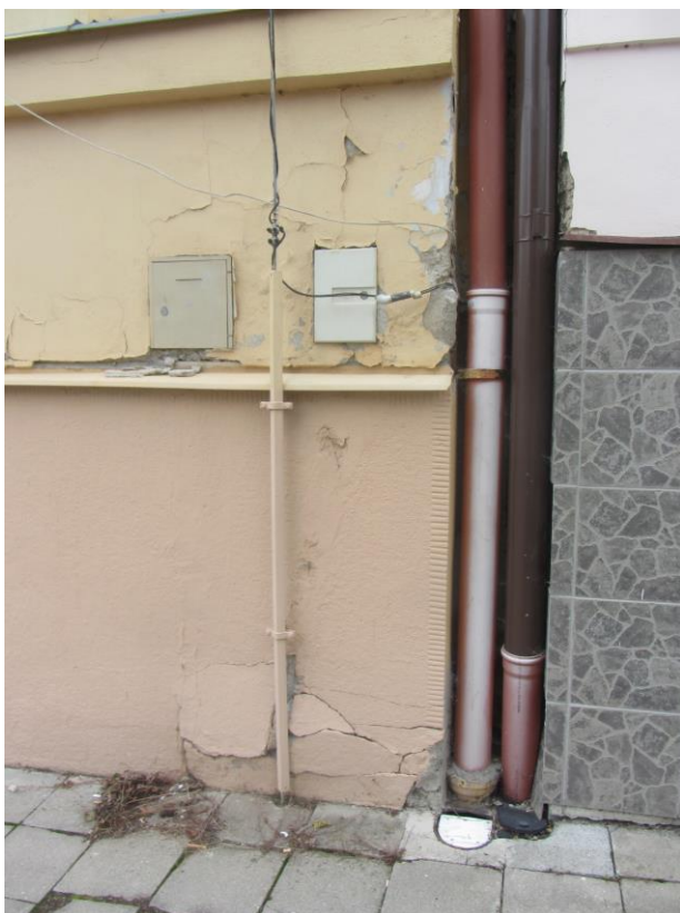
příklad degradace teracové vrstvy, omítkové vrstvy nad terasovým soklem
