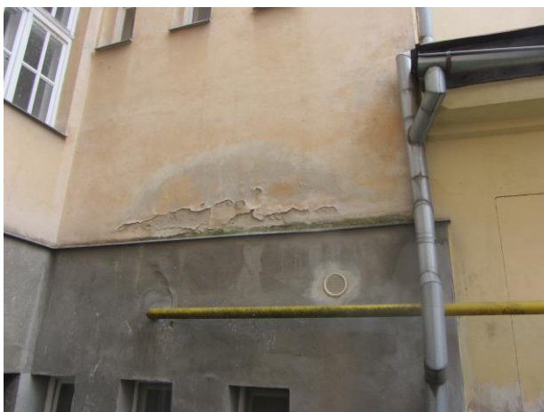
dvorní fasády – degradace omítkových vrstev nad soklem
