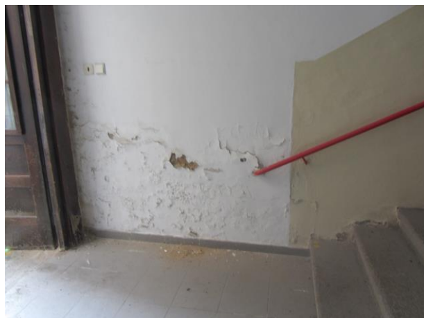
degradace povrchových vrstev v interiéru
